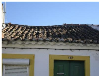
**Figura 6** – Exemplo de edifícios com patologia muito grave ao nível da cobertura
