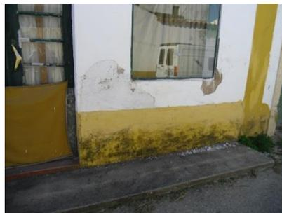
**Figura 7** - Exemplo de edifícios com patologia grave ao nível das paredes exteriores
